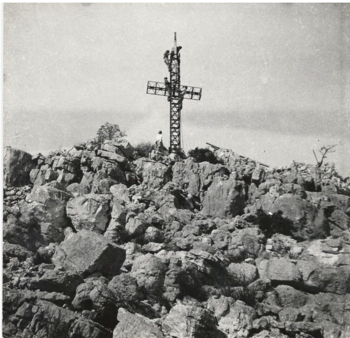
Fot.6. Podnoszenie ramion krzyża (dwa elementy „Crib” – łączna długość 3,7 m. waga 180 kg). Na samej górze, przygotowany do odbioru ramion, posadowienia na konstrukcji i montażu – plut. Tadeusz Szklarek przy współpracy kolegów. U podstawy konstrukcji stoi por. Wacław Kulikowski. Maj 1944 r. (III dekada).
