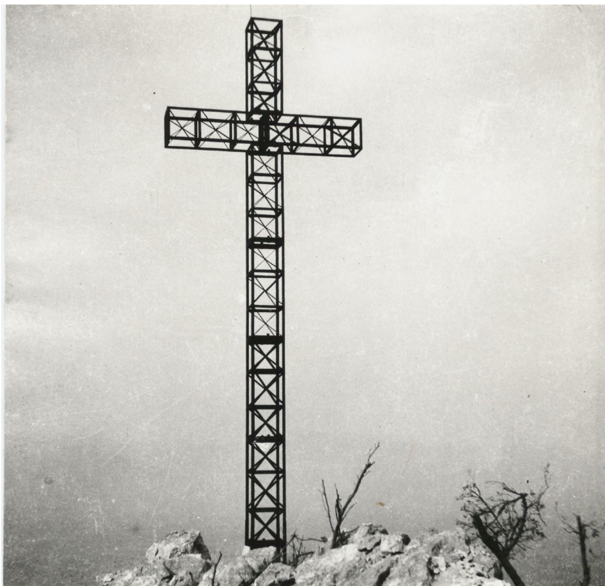
Fot.10. Zakończenie prac związanych z budową krzyża pomnika 5. KDP na wzgórzu „575” w rejonie Monte Cassino (widok odstrony wsch.). Wysokość od fundamentu ok. 11,7 m., ramiona 3,7 m. „...stanął na straży poległych żołnierzy Dywizji Kresowej, na znak ofiary dla Ojczyzny dla Jej Wolności i Niepodległości...” (K. Kleszczyński). Poświęcenia dokonał kapelan 5. KDP w dniu 13.06.1944 r. (byliśmy nieobecni). Czerwiec 1944 r. (I dekada). Fot. plut. Tadeusz Szklarek – 4. Komp. 5. Baon Sap. 5. KDP.
