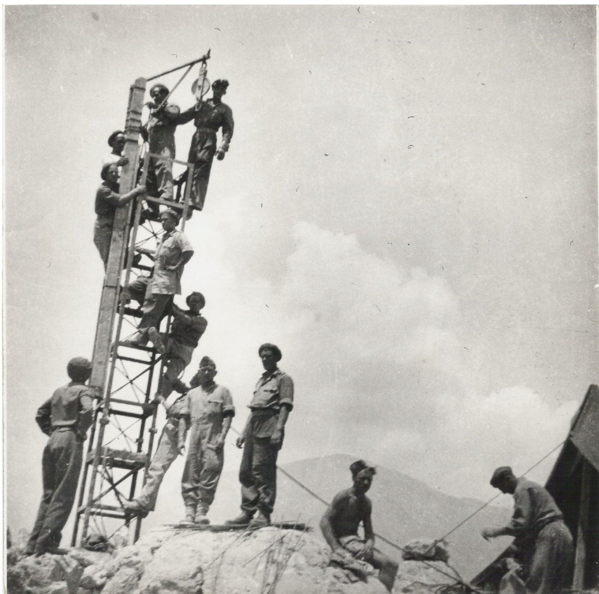
Fot.4. Montaż wysięgu (belka drewniana 12 x 12 cm), zaczepy o kratownicę na dolnym końcu belki i w jej 1/3 długości tak, by kratownica wciągana ku górze, mogła być posadowiona w całej swej wysokości na konstrukcji i montowana (klamrowana obejmkami i skręcana). Ramię wysięgu – zblocza, również prowizoryczne, przywiązane do belki linką konopną. Całość montażu na górze konstrukcji (stoi z lewej strony), przy pomocy zabezpieczenia przez kolegów od dołu, wykonywał plut. Tadeusz Szklarek. Wysięg (belkę) każdorazowo przemieszczano ręcznie. W głębi zdjęcia widoczna w tle góra Cairo. Maj 1944 r. (III dekada).
