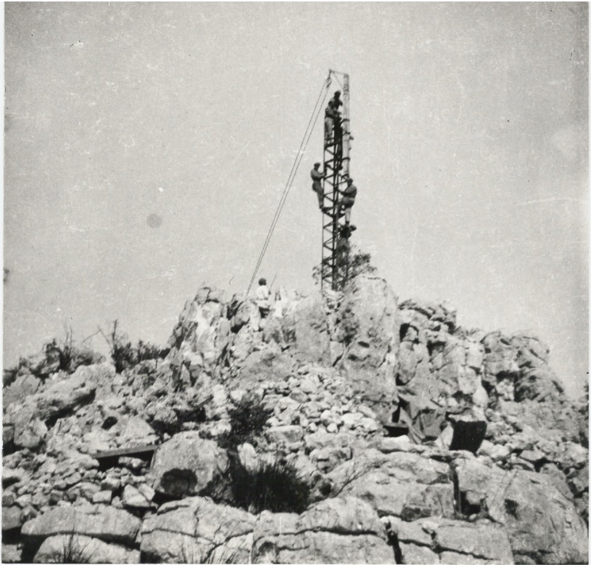
Fot.5. Przemieszczenie wysięgu montażowego ku górze i zabezpieczenie na konstrukcji. Na dole z lewej strony stoi por. Waław Kulikowski. Na samej górze, stojąc na konstrukcji, montażu dokonuje plut. Tadeusz Szklarek. Maj 1944 r. (III dekada).
